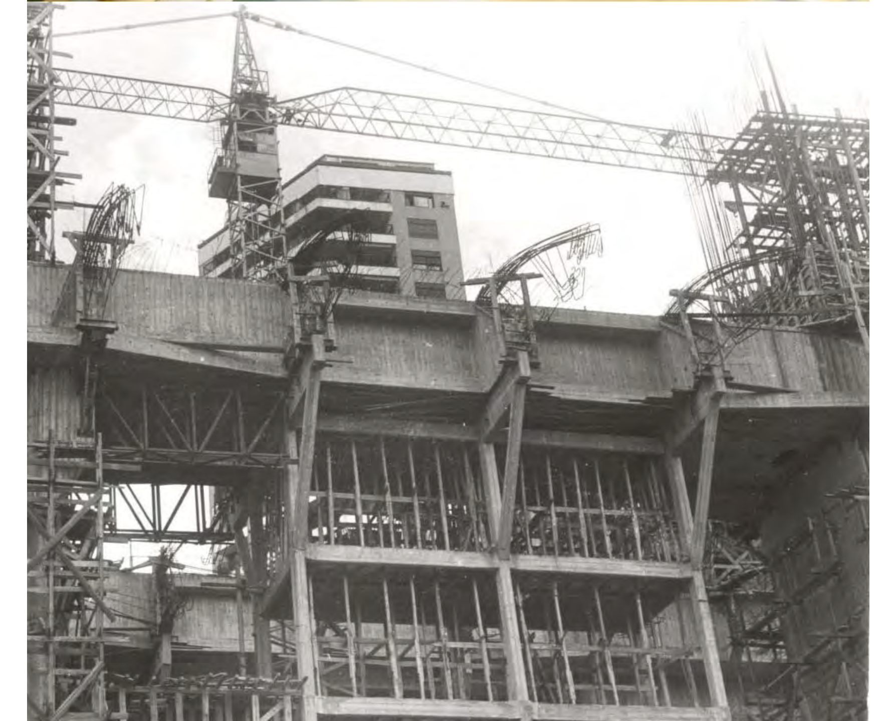
Fig. 3. Testa, C., Bullrich, F. y Cazzaniga de Bullrich, A. (1958-91). Biblioteca Nacional Mariano Moreno. Arriba, fotografía de modelo a escala del proyecto concursado, en varillas de madera de pino. Abajo, la Biblioteca en construcción. Fuente: Archivo Patrimonio Histórico del Edificio Biblioteca Nacional
